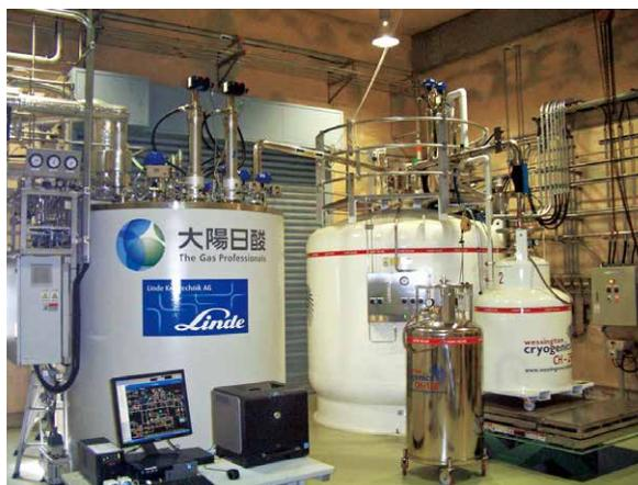
図1: 低温科学部(片平地区センター)に設置されているヘリウム液化機
