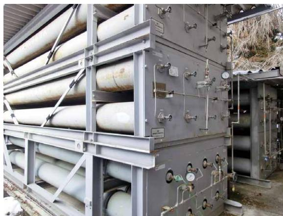
図2: 低温科学部(片平地区センター)の回収ガスヘリウム貯蔵用長尺高圧ボンベ群
