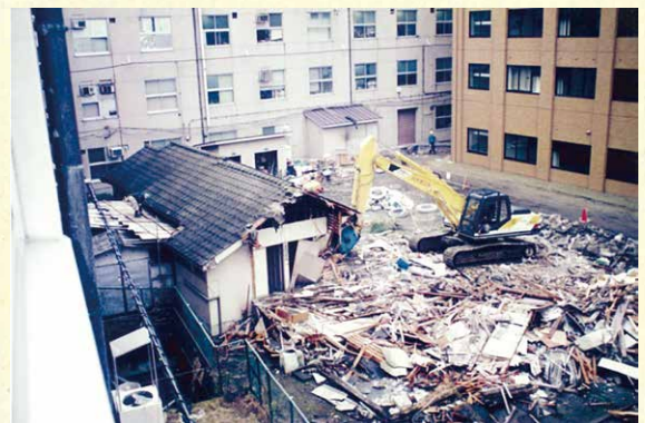
写真6: 平成5年むつみの取り壊し(研友51号より)
