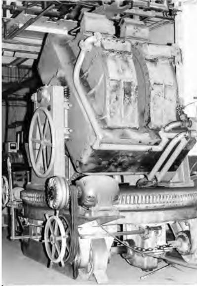
写真5 ヘリウム液化機と並行して整備された極低温生成用大型電磁石(昭和55年(1980)頃)。場所は、1930年代に空気液化機と水素液化機が置かれていた低温化棟の一室である。
