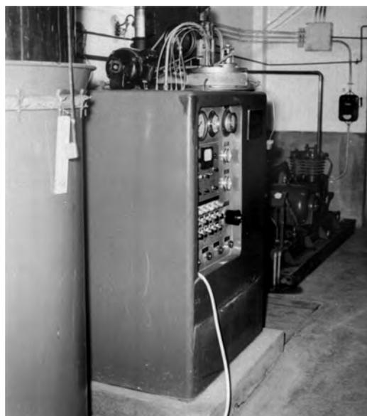
[写真4] コリンス型ヘリウム液化機(昭和30年(1955)頃)。現在は金研2号館玄関に展示されている。(東北大学史料館写真データベースより)
