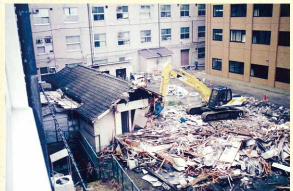
写真6: 平成5年むつみの取り壊し(研友51号より)
